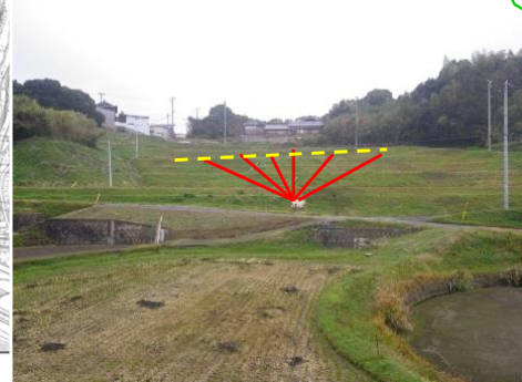
対策工施工後 (Hブロック) ・杭工(鋼管杭) 29本 ・地下水排除工(水抜きボーリング) L=55m×6本
